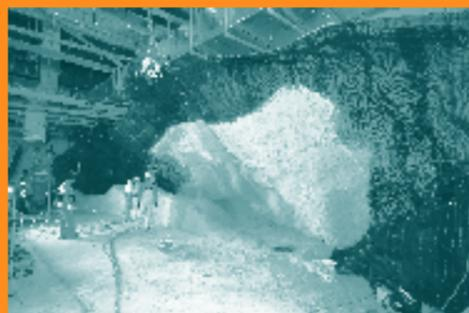
Des sculpteurs modèlent et patinent ensuite ce béton en restituant la géologie de la grotte. Une partie des spéléothèmes est réalisée en atelier, l'autre partie sera réalisée in situ selon le type de concrétion à réaliser. Les sculpteurs de la grotte laissent des espaces vides pour insérer les panneaux ornés également réalisés en atelier afin de les intégrer lors de la dernière étape de construction de la grotte.
